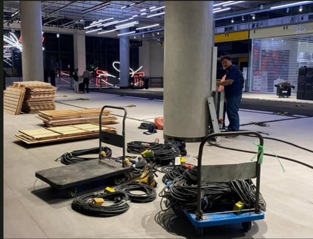
02 / ติดตั้งและเตรียมระบบ
